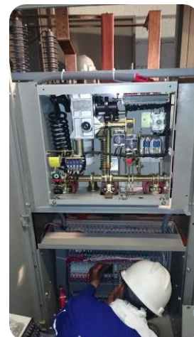
Modificaciones a Tablero existente para incremento de funciones
